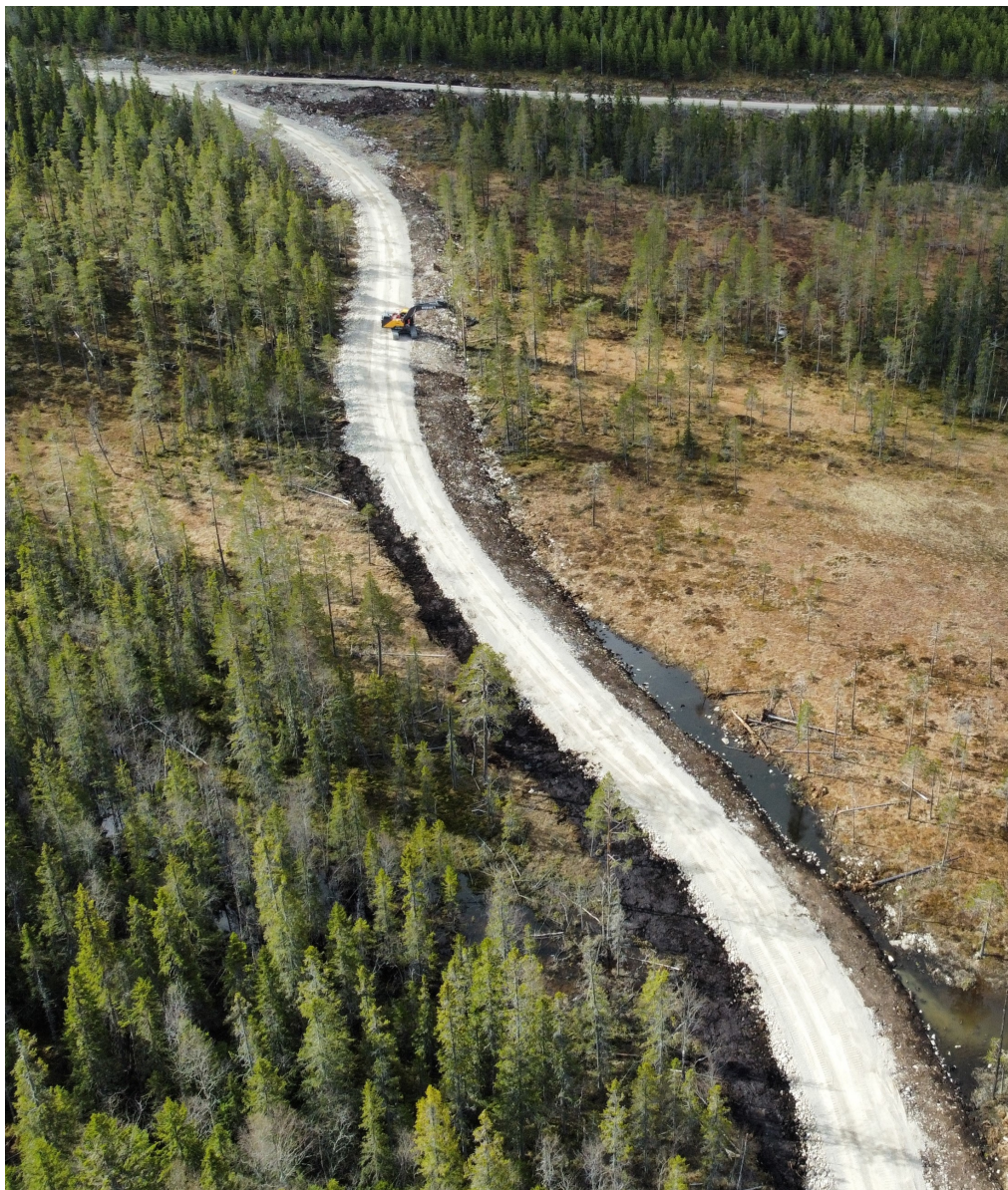
Väg över Nordanbergsmynen.
